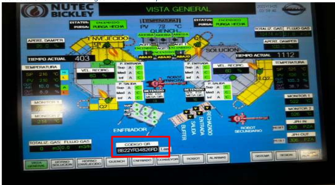
Ilustración 5.19: Vista general. Fuente: Propia.
